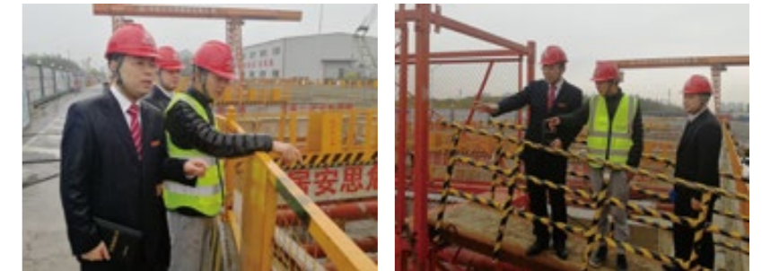
绍兴分行客户经理走访绍兴地铁施工现场，了解企业需求
