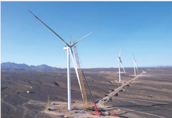
▶ 华夏金租履带式起重机参与中船哈密项目吊装
