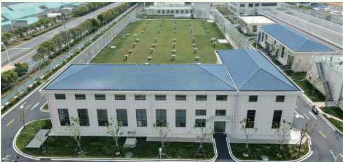
▲ 本行支持的一体化供水项目
