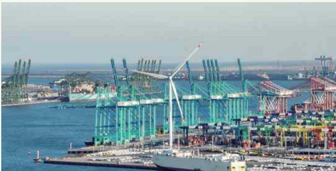
▲ 本行支持的某港口建设项目
