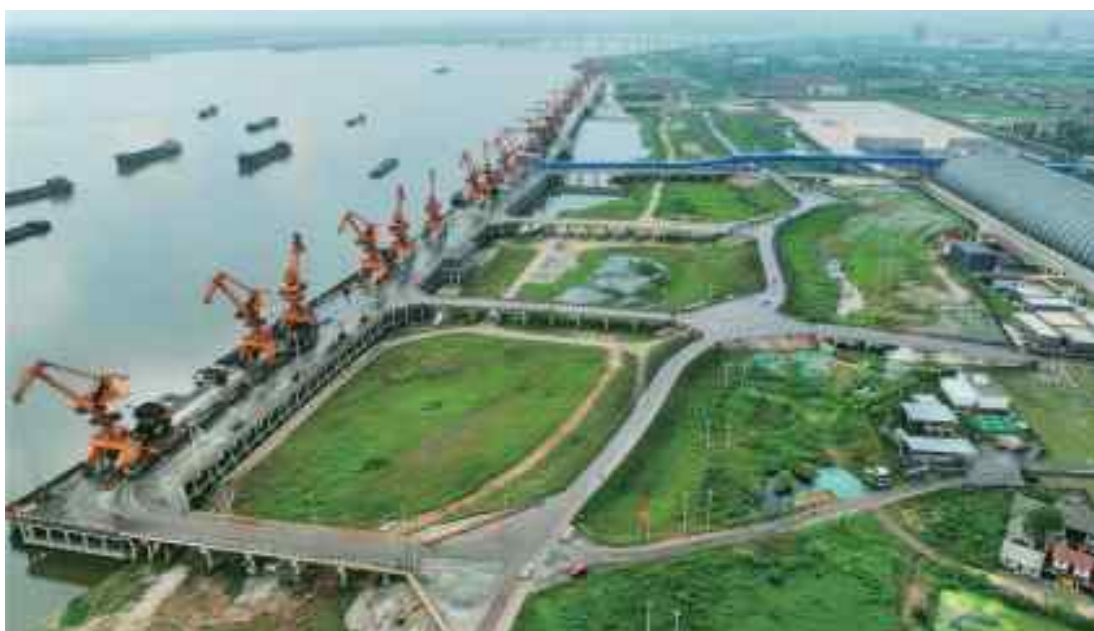
▲ 南昌港东新港区姚湾作业区综合码头工程项目建设
