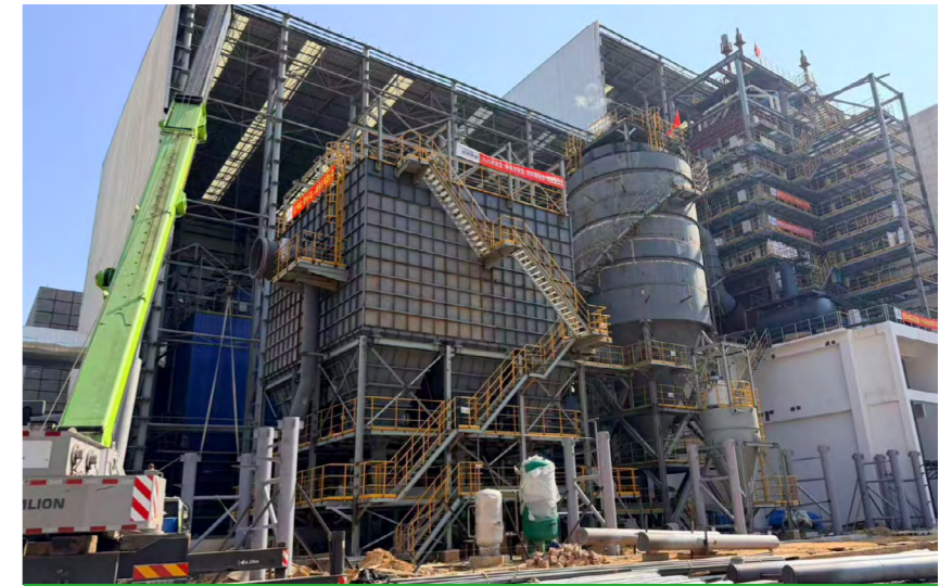
“生活垃圾焚烧发电厂二期”工程建设场地。
