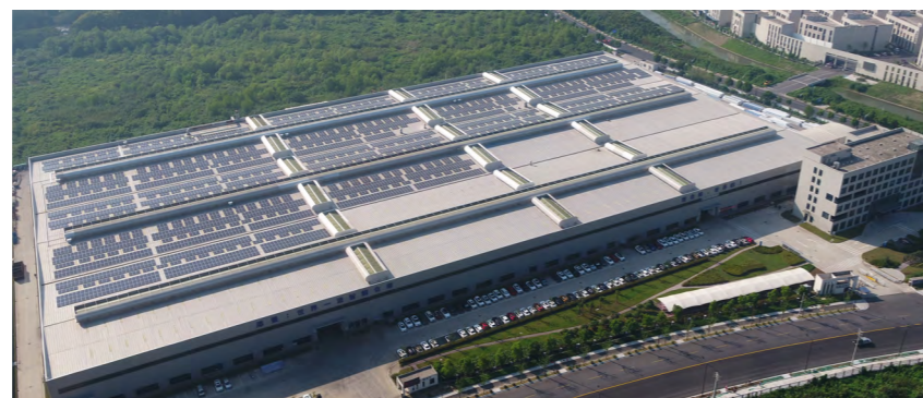
湖州现代物流装备高新技术产业园区铺设太阳能光伏板。
